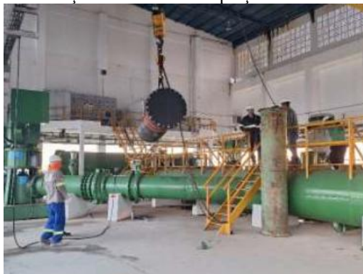
Figura 6 - Preparação de tubulação para instalação de bomba na captação na ETA I.
