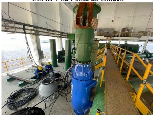
Figura 8 - Mudança de posição da bomba Higura EEAB 1 na Ponta do Ismael.
