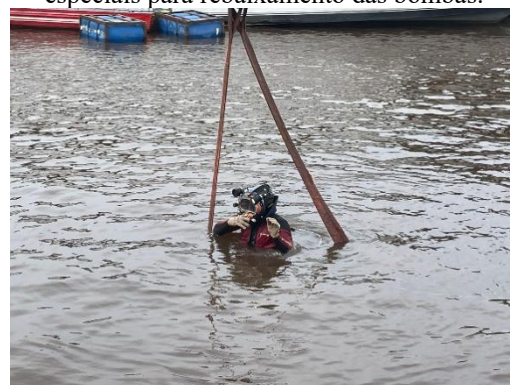
Figura 5 - Uso de mergulhadores e equipamentos especiais para rebaixamento das bombas.
