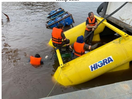
Figura 4 - Equipe de mergulhadores realizando rebaixamento da bomba anfíbia e realização de limpeza.
