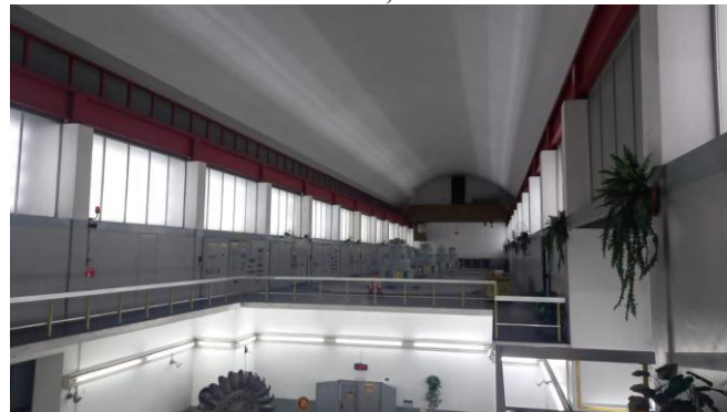
Figura 1. Janelas falsas na parte superior da parede da casa de bombas da Usina Parigot de Souza, localizada no meio do morro em Antonina, litoral do Paraná
