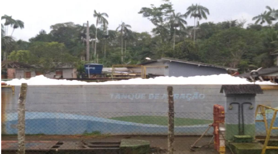
Figura 1 – Estação de tratamento de resíduos localizada às margens do Igarapé/Rio Urubuí, no município de Presidente Figueiredo (AM).
