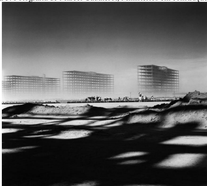
Figura 3: Fotografia de Marcel Gautherot, Ministérios em construção, 1958.
