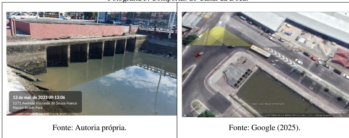
Fotografia 3. Comportas do Canal da Doca.
