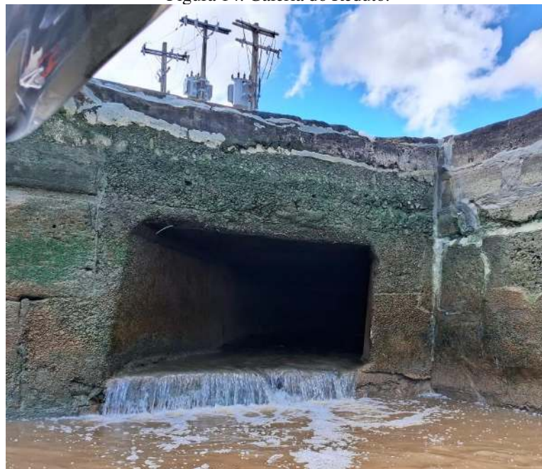
Figura 14. Galeria do Reduto.
