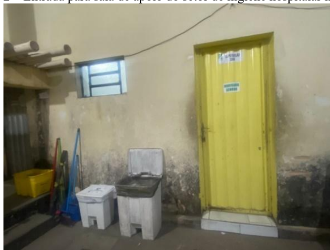
Figura 2 – Entrada para sala de apoio do setor de higiene hospitalar no HRPE
