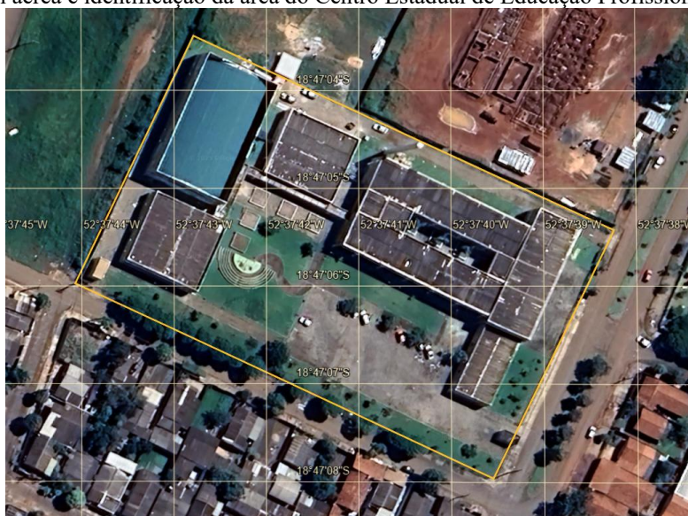
Figura 1. Imagem aérea e identificação da área do Centro Estadual de Educação Profissional Arlindo Neckel
