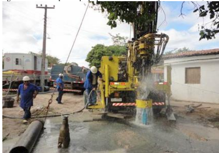
Figura 2 – Perfuração de poço profundo no município de Uruoca, Ceará
