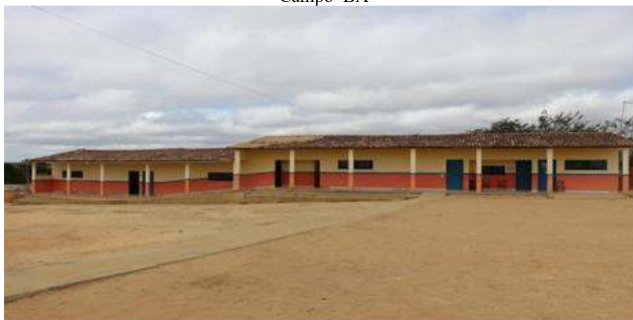
Figura 2. Fachada da Escola Municipal Maria Ferraz de Oliveira (EMMFO), localizada no povoado Periperi, Belo Campo–BA
