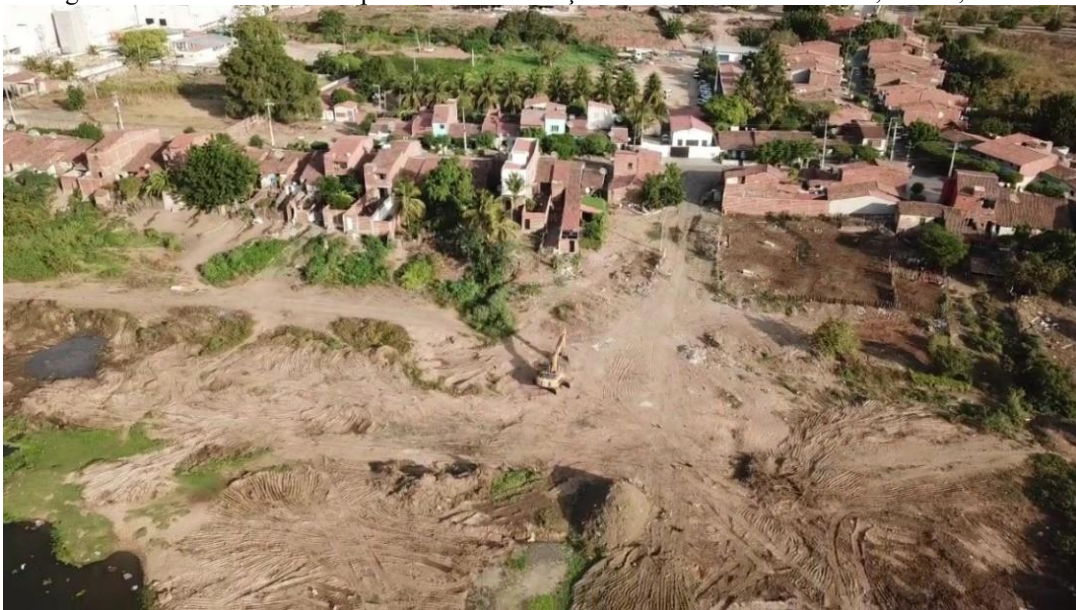
Figura 7. Uso de drone no mapeamento da execução de talude. Bairro Sumaré, Sobral, Ceará.
