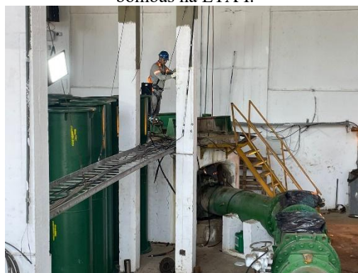
Figura 7 - Manutenção para rebaixamento das bombas na ETA I.
