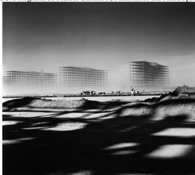
Figura 3: Fotografia de Marcel Gautherot, Ministérios em construção, 1958.
