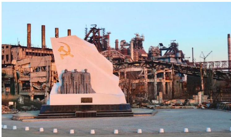
Figura 2 - Fachada do complexo metalúrgico e siderúrgico de Azovstal
